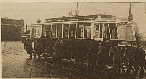
Schulkinder helfen einen Strassenbahnwagen in sein Depot schieben.
