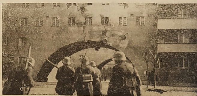
Eines der Tore der Riesenarbeitersiedlung „Karl Marx Hof“ nach der Beschiesung und Einnahme durch die Regierungsstruppen.
